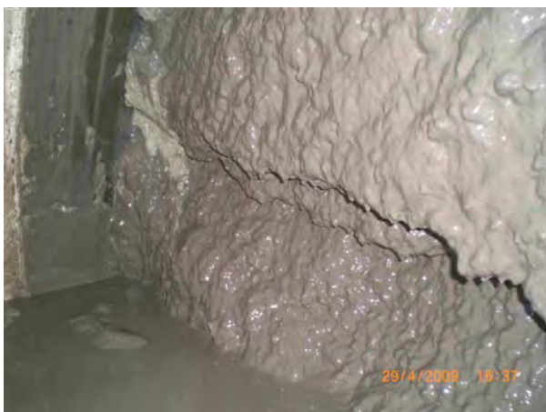
Bild 6: Ortsbrust in sehr durchlässigen Kiesen
