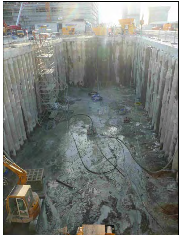
Bild 3: Startgrube Vorlauf im Zwischenaushubzustand
