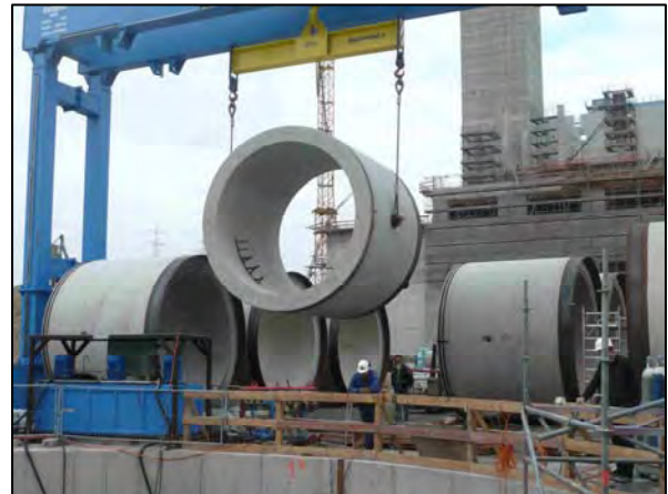
Bild 5: Einbau der 40 t schweren Vortriebsrohre
