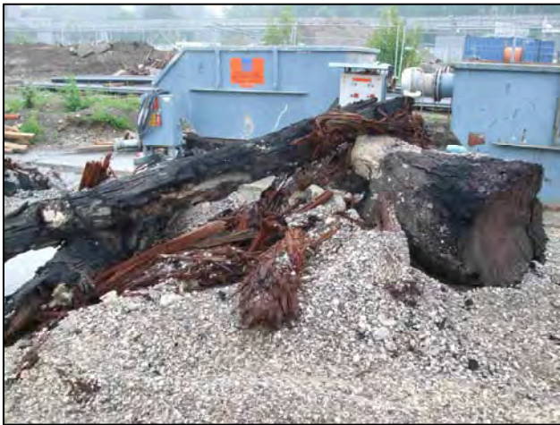
Bild 8: Bergung eines im Baugrund abgelagerten alten Holzstammes beim Aushub der Startgrube Vorlauf
